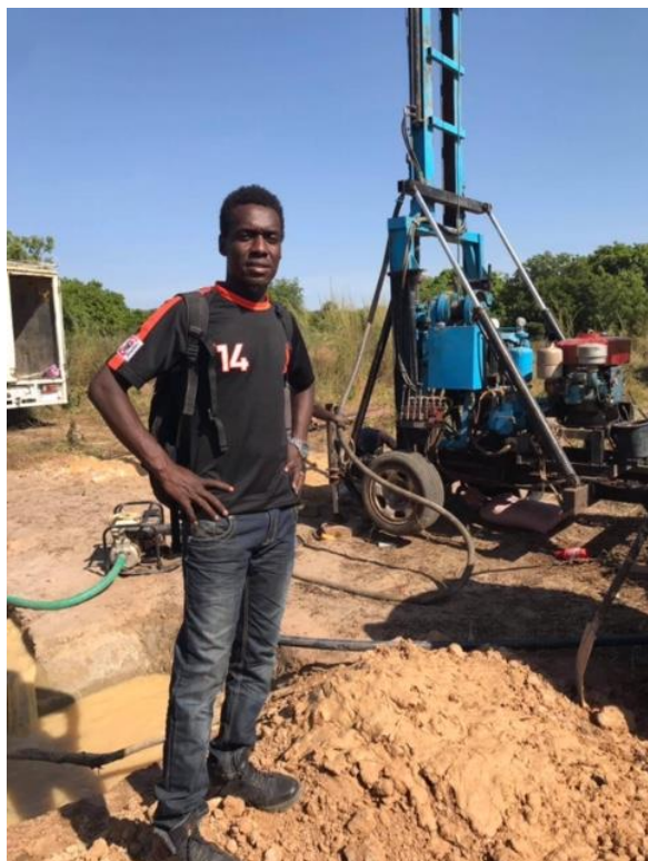
Projektleder Ousman Bah – der bores efter vand i 40 meters dybde
