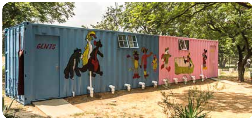
Foto: © Københavns Rotary Klub. Etablering af Toiletter på skole i Sydafrika med bidrag fra Rotary Danmarks Hjælpefond og distriktsmidler.
